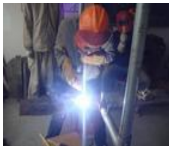
现场焊接施工
