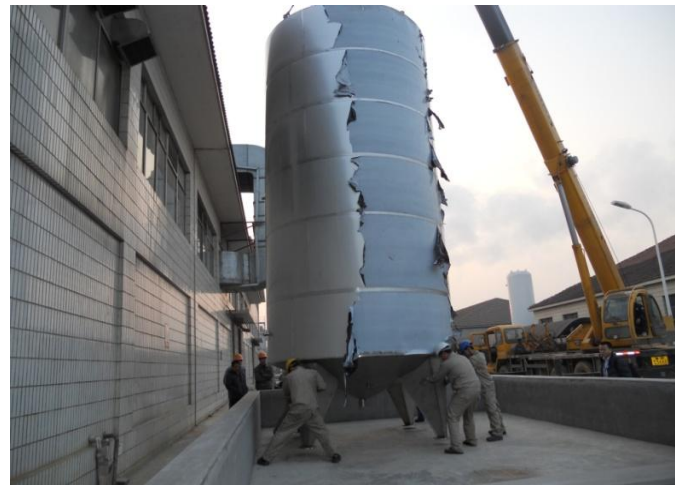
50T 恒温型果葡糖浆储存罐的吊装现场
